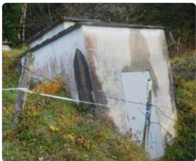
Réservoir d'eau potable de Germagnat
