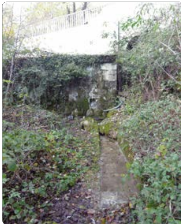
Le réservoir de Ceillat
