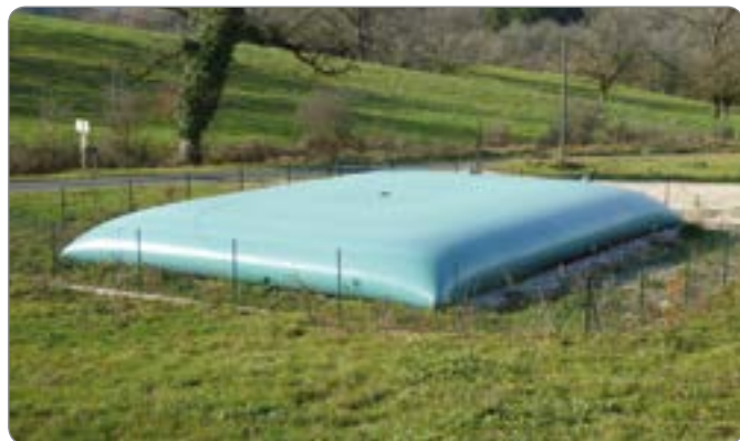
Réserve incendie de Toulangeon
