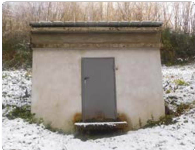
Captage de la source de la Sablière
