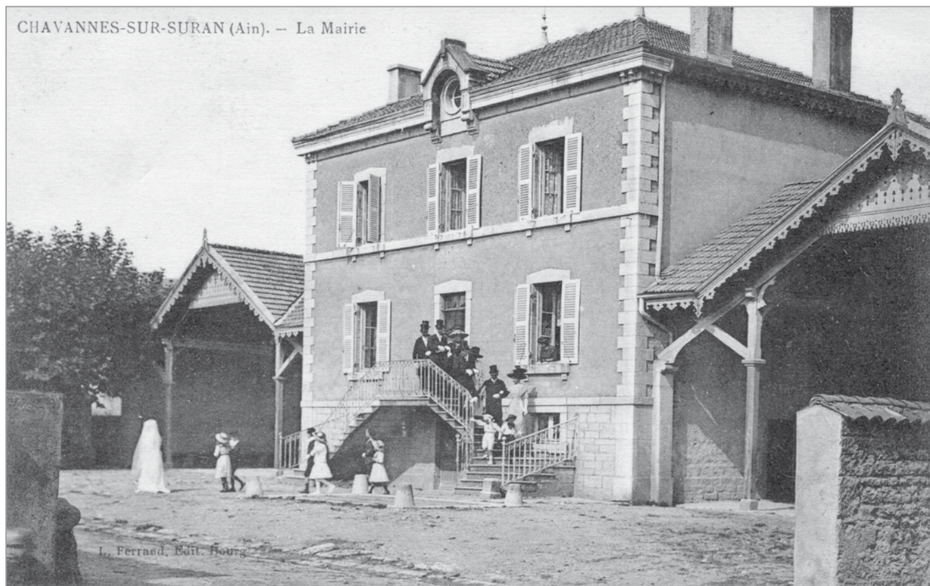
L' ancienne mairie avant le sinistre
